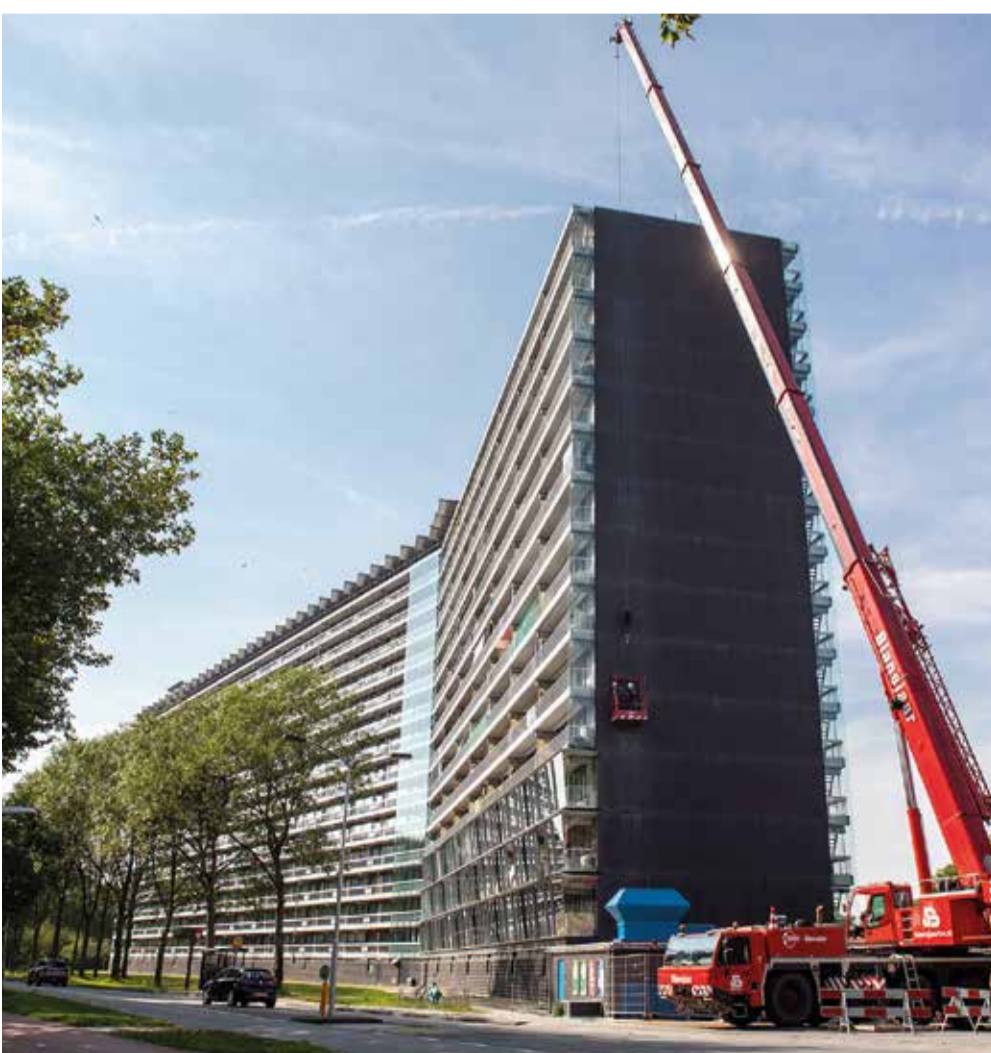
In augustus werd de schoorsteen voor de HulpWarmteCentrale (HWC) gemonteerd bij de Brandaris. Fotograaf: Jorrit 't Hoen
